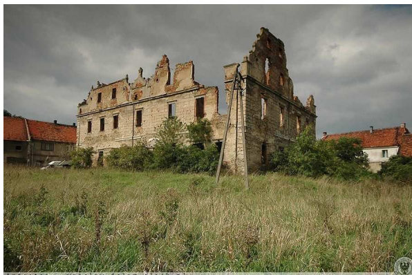
Fot. Widok z południowego wschodu.
